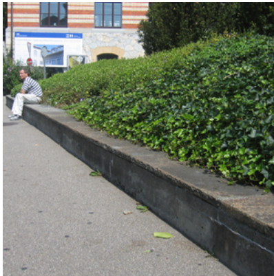
Betonmauer mit Abdeckung
