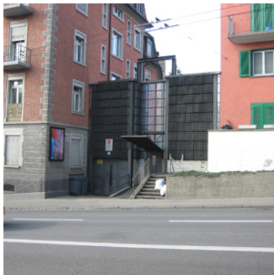
Lärmschutzwand mit Zugang zu privatem Aussenraum
