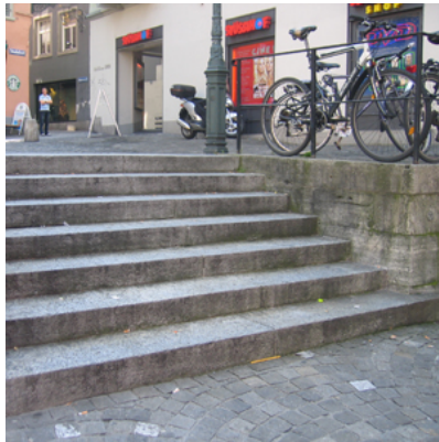
Historische Treppe mit Blockstufen aus Quarzsandstein oder Granit
