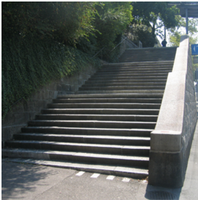
Blockstufen aus Granit
