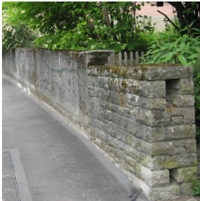
Abgestufte Naturstein-/ Betonmauer
