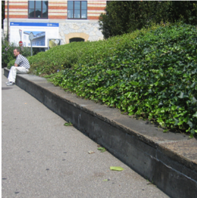
Betonmauer mit Abdeckung
