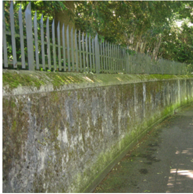
Betonmauer entlang historischer Grünanlage
