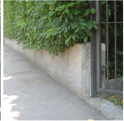
Sockelmauer Beton
