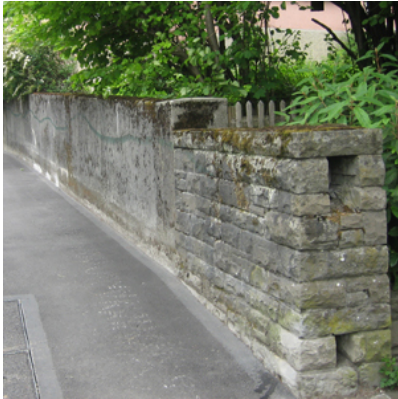
Abgestufte Naturstein-/ Betonmauer
