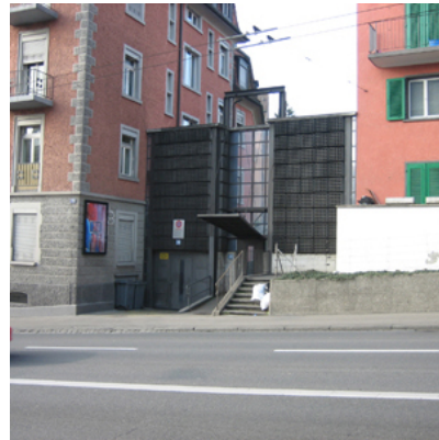
Lärmschutzwand mit Zugang zu privatem Aussenraum
