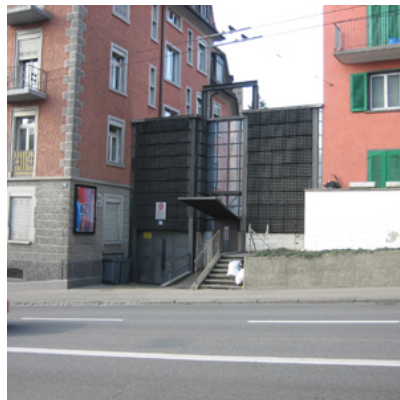
Lärmschutzwand mit Zugang zu privatem Aussenraum
