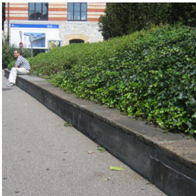
Betonmauer mit Abdeckung
