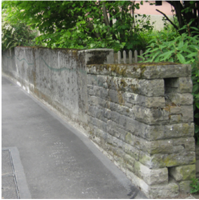
Abgestufte Naturstein-/ Betonmauer
