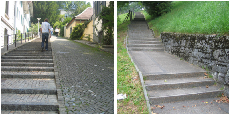
Kombinierter Treppen-Rampenweg Treppenweg
