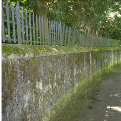
Betonmauer entlang historischer Grünanlage
