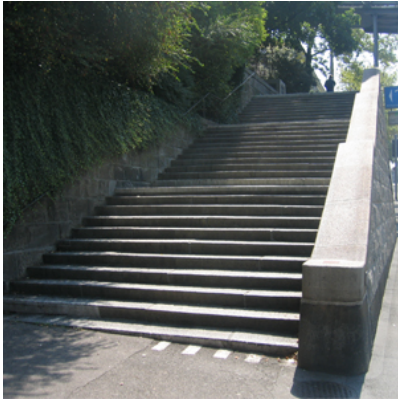
Blockstufen aus Granit
