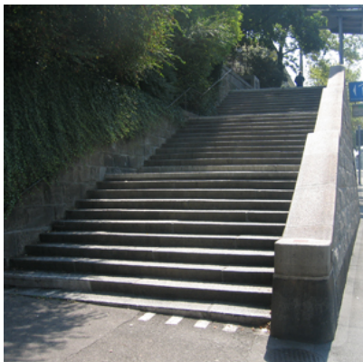
Blockstufen aus Granit
