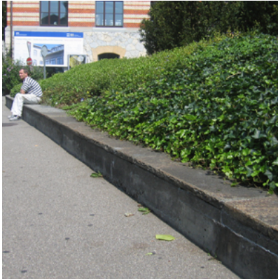
Betonmauer mit Abdeckung
