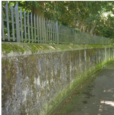
Betonmauer entlang historischer Grünanlage
