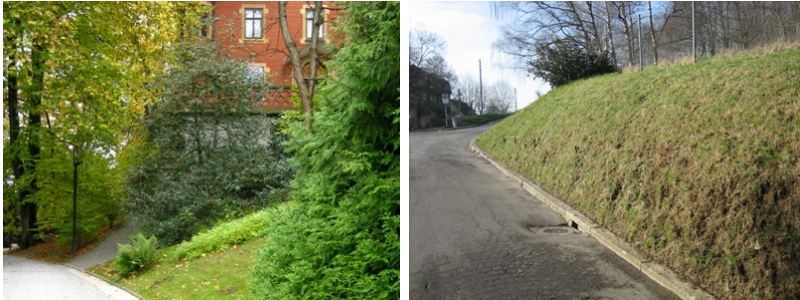
Böschung in historischer Grünanlage Stark abfallende Böschung
